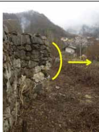
Spanciamento della parte mediana del muro
