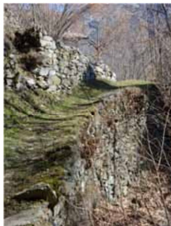
Muretti funzionali al tracciato: a monte del muro trattengono il terreno del versante, a valle sostengono la mulattiera - Val Sabbiola
