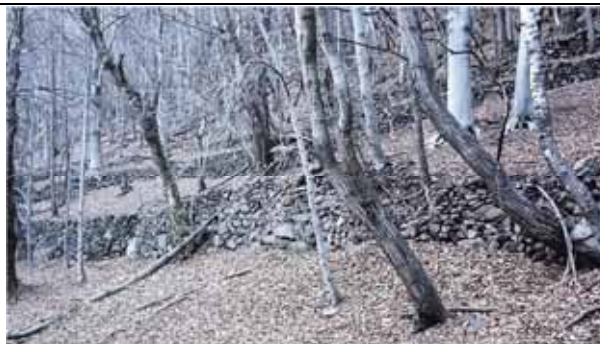
Serie di terrazzamenti agricoli, ora abbandonati, con crescita incontrollata delle piante e progressivo crollo dei muretti in pietra a secco
