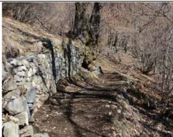
Muretto per taglio del pendio e inserimento di sentiero - Sabbia
