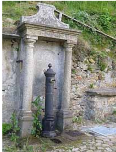
Rinzaffo di malta cementizia su muri in pietra a secco
