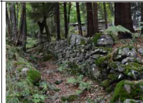
Abbandono, incuria e progressiva invasione da parte del bosco
