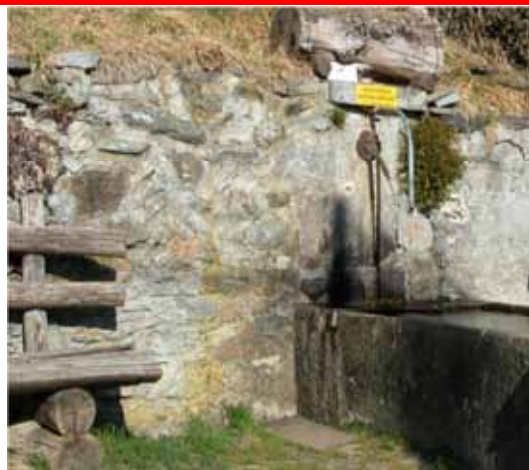
Rinzafo in malta cementizia
