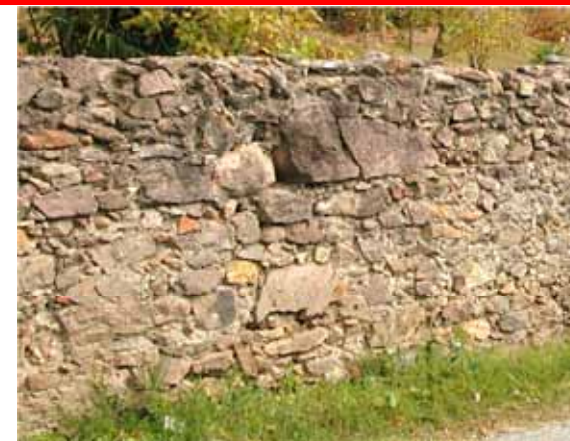
Allettamento con malta
