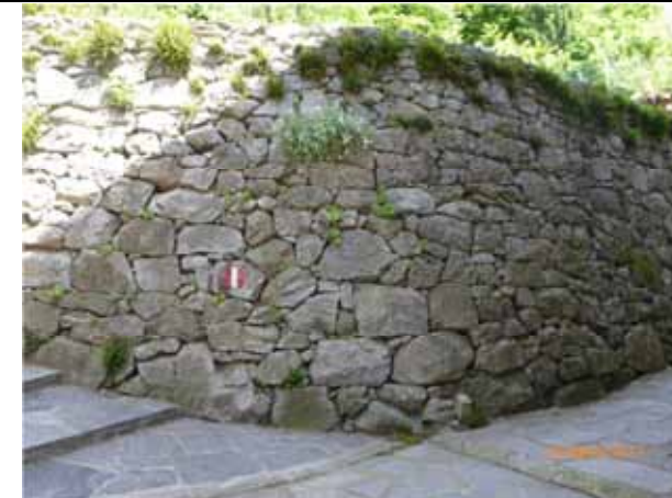
Muraglione di contenimento terreno in pietre di granito - Vanzone
