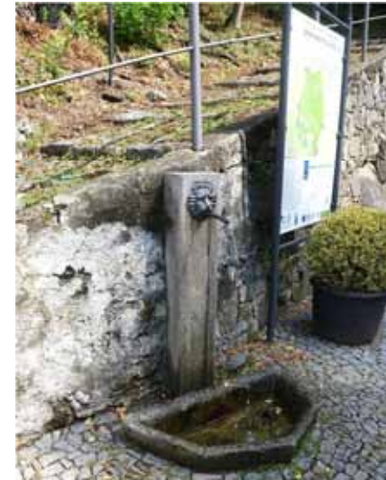
Risarciture e rinzaffo di malta su vecchio muro a secco
