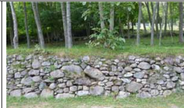
Muretto in gabbri, con presenza di elementi di grandi dimensioni - Brugaro
