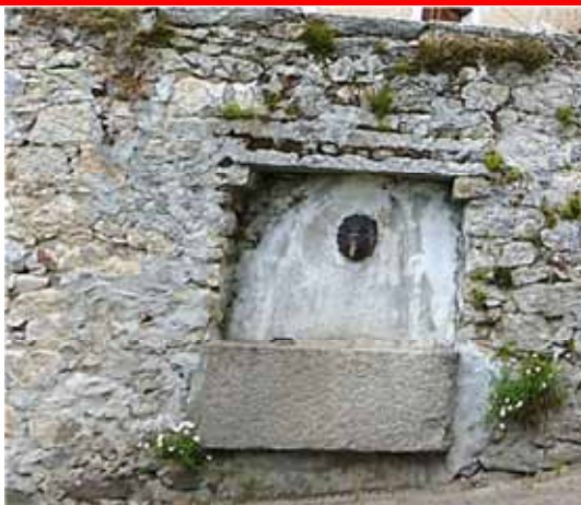
Rinzafo in malta cementizia
