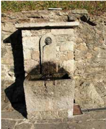
Muri in pietra con malta di allettamento
